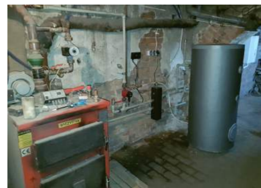
Przed modernizacją kotłowni
